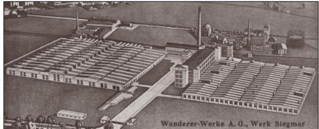
*Wanderer-Werke, Betriebsteil Siegmarsdorf, 1930, rechts die Auto-, links die Fräsmaschinenfertigung. Im Mittelteil erfolgte nach der Bildung der Auto-Union noch der Bau von Verwaltungsgebäuden und kleineren Flachbauten.*
